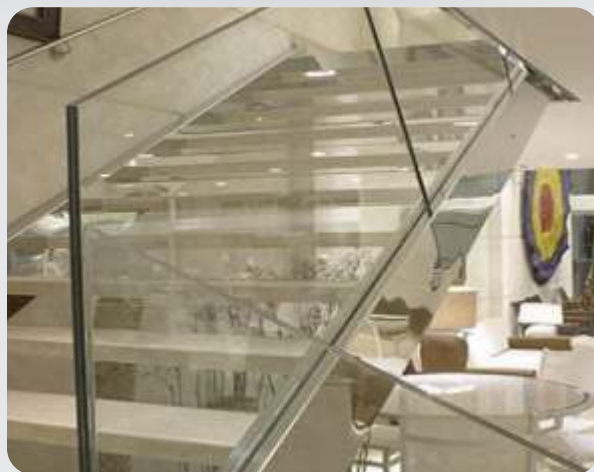
Escada em Aço Inox e vidro com degrau revestido de mármore
