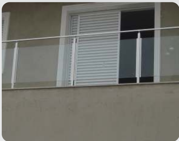
Guarda Corpo Aço Inox com vidro laminado e sistema de fixação com canaleta
