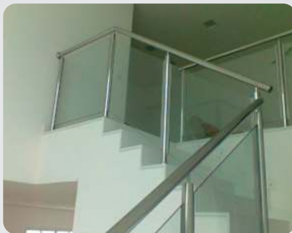
Guarda Corpo Aço Inox com vidro laminado e sistema de fixação com canaleta
