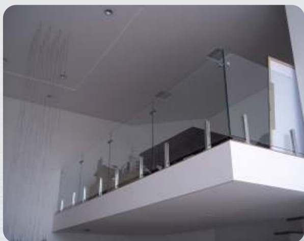
Guarda Corpo com vidro temperado com torre em aço inox
