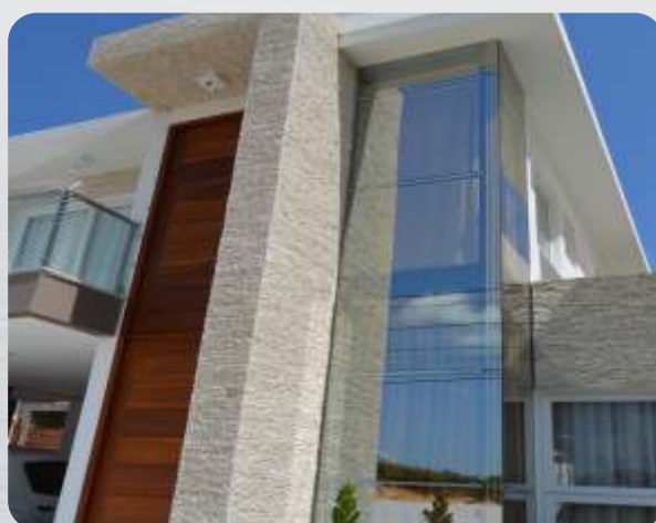
Envidraçamento de Fachada
