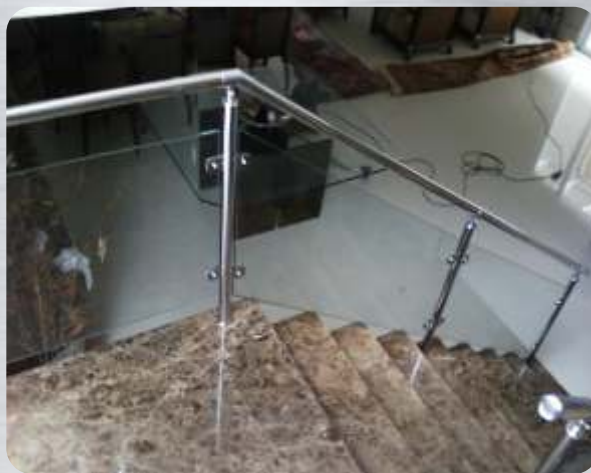
Guarda Corpo em Aço Inox vidro temperado com sistema de fixação em presilhas
