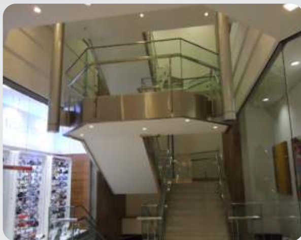
Revestimento em Inox para escada de alvenaria
