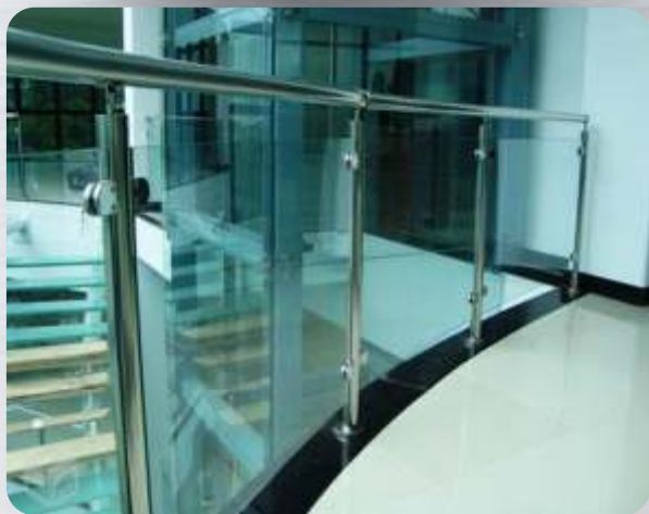
Guarda Corpo Aço Inox e vidro temperado sistema de fixação presilha
