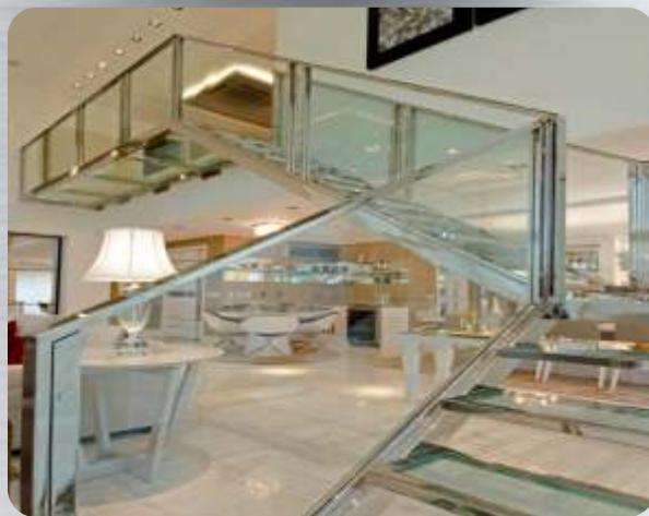
Escada em Aço Inox com perfil retangular com vidro multilaminado e degrau em vidro
