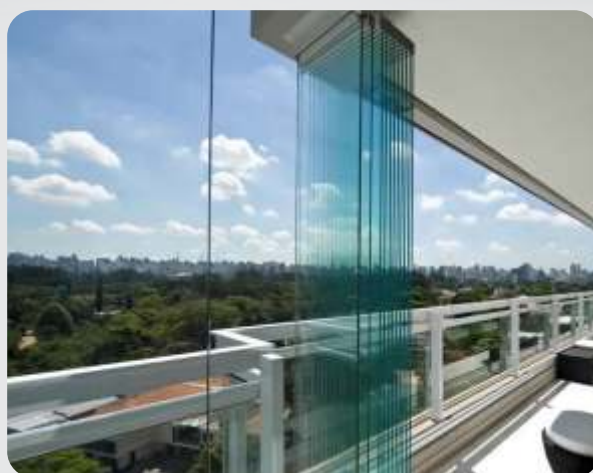
Envidraçamento de Sacada
