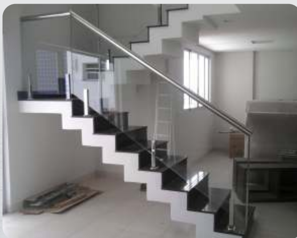
Corrimão Aço Inox Sobreposto ao Vidro
